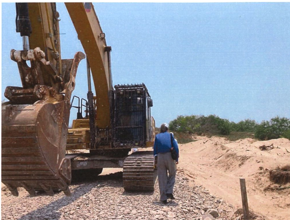
Visita la sitio en donde se construye la barda perimetral del puerto
